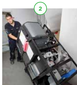
Binnenbrengen nieuwe ketel
